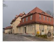
Fot. 11. Dworzec kolejowy w Świeradowie-Zdroju, obecnie Miejskie Centrum Kultury (fot. K. Czartowski, archiwum NID)
